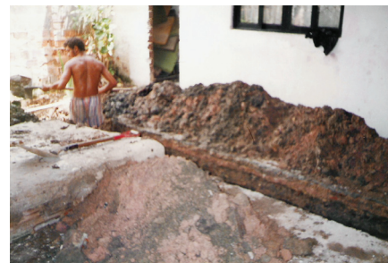
Figura 26 Construção de redes básicas em sistemas condominiais. Método convencional, cuidados especiais pela proximidade das casas.
