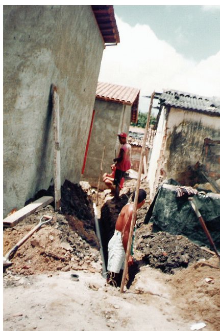
Figura 42 Ramais condominiais em construção no Recife.
