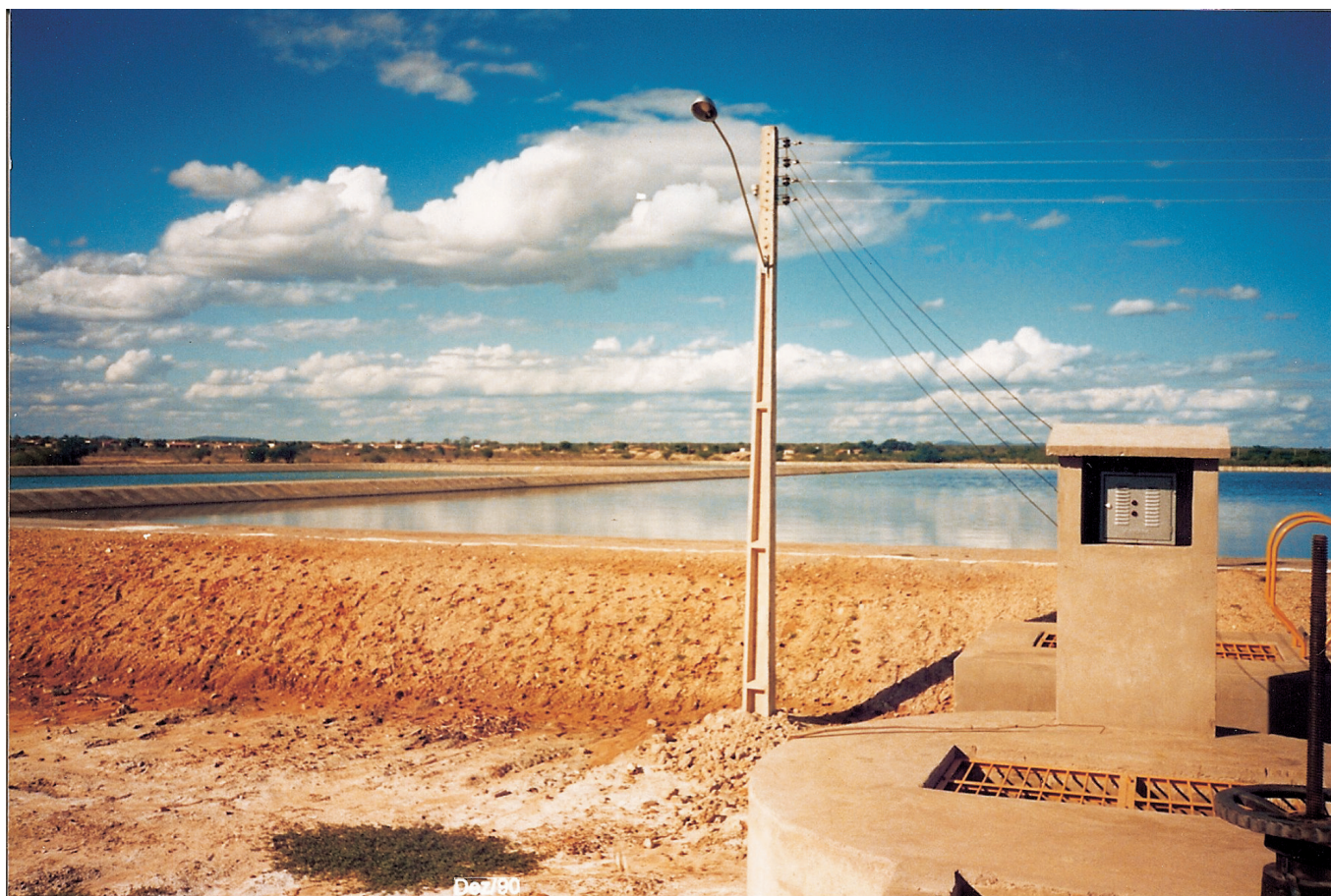
Figura 62 Uma das 11 lagoas de estabilização da cidade, desta feita conforme o desenho convencional
