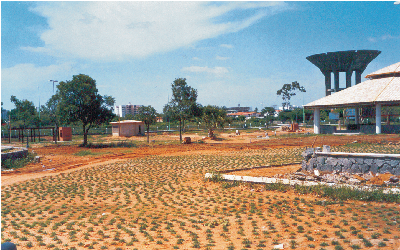
Figura 60 Plantio do Parque da Cidade com apoio da irrigação com águas de lavagem dos filtros da ETA
