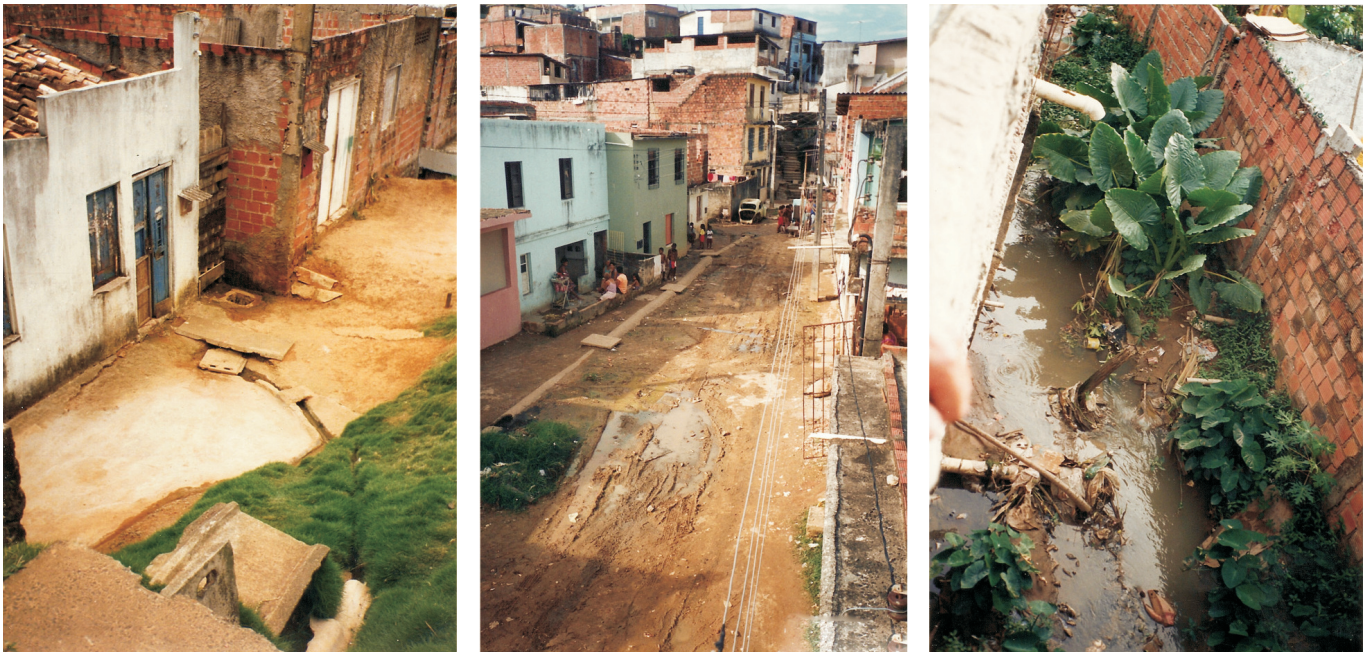
Figura 77 Os sistemas unitários em Salvador são muito precários do ponto de vista sanitário e, além disso, são sérios obstáculos para o êxito do sistema separado
