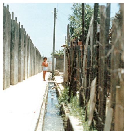
Figura 3 Niveles de solución espontánea: la zanja, la canalización precaria y el sistema unitario a cielo abierto
