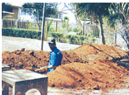
Figura 14 El sistema condominial en los barrios ricos de Brasília (arriba, vista aérea de un condominio; abajo, un ramal interno)
