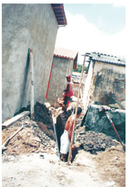
Figura 42 Ramales condominiales en construcción en Recife
