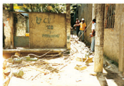
Figura 93 La jerarquía del poder determinando la forma del abastecimiento de agua; de la lata en la cabeza, a las instalaciones precarias y a las complejas estaciones de bombeo
