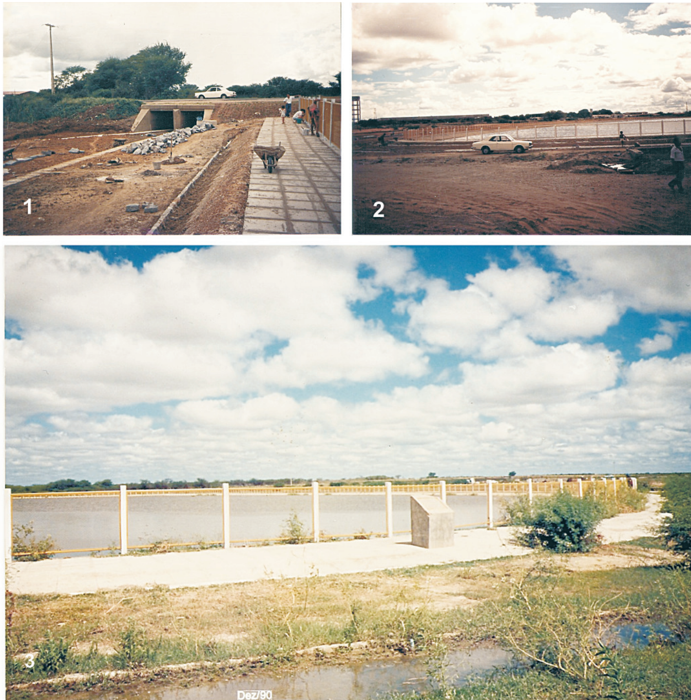
Figura 59 La transformación de la laguna: en la construcción de sus obras complementarias (1), liberada al tránsito (2) y con su urbanización concluida pero ya degradada (3)
