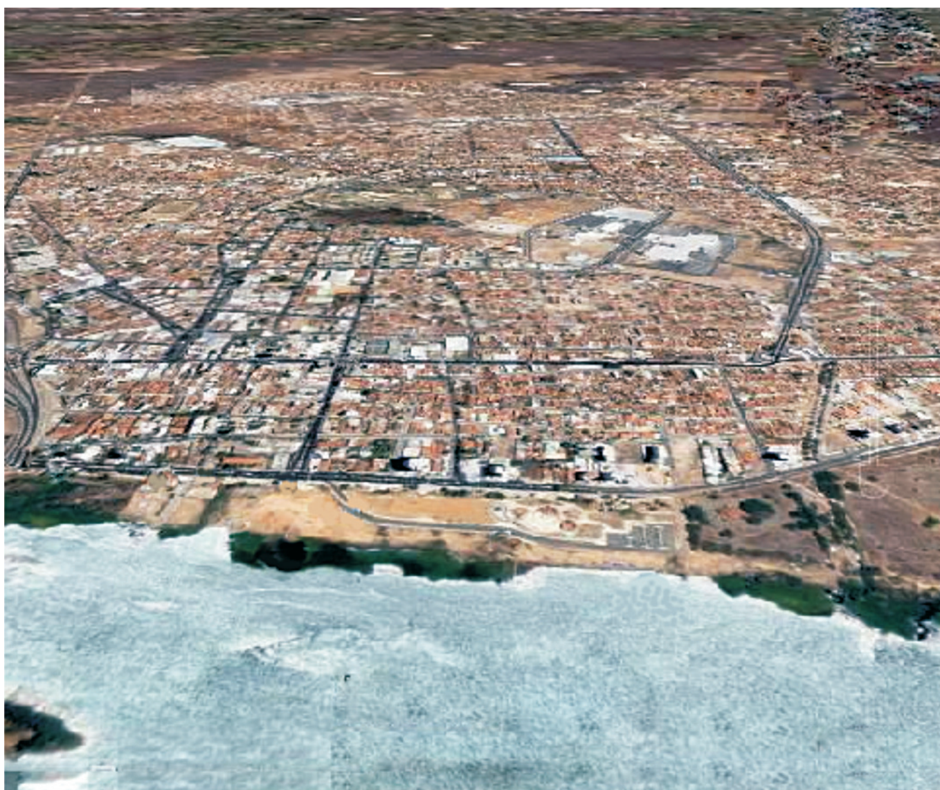
Figura 52 Vista aérea de la ciudad, bañada por el río San Francisco, denotando su organización urbana
