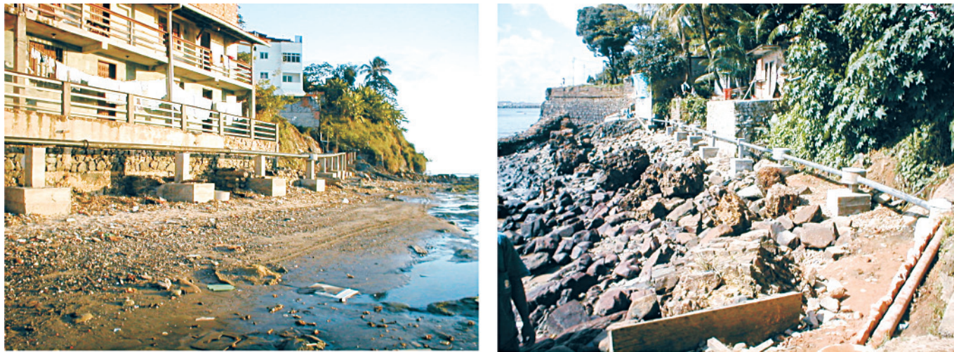
Figura 81 Fotos de colectores apoyados en pilares, en la Bacia do Comercio, en área de construcciones en barrancos a la orilla del mar
