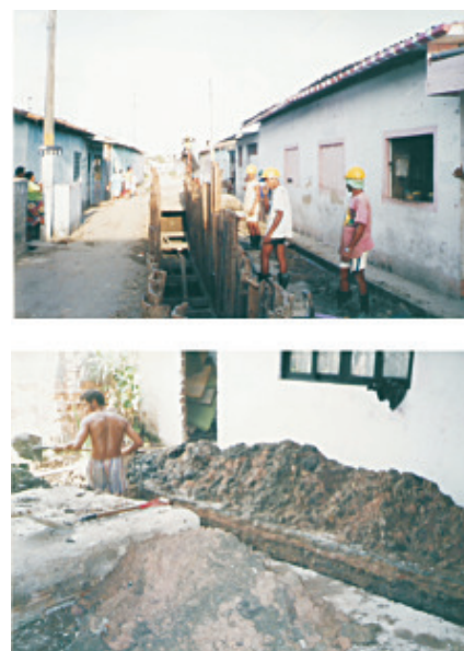
Figura 26 Construcción de redes básicas en sistemas condominiales. Método convencional, cuidados especiales por la proximidad de las casas
