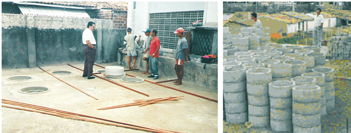
Figura 40 Fabricación y almacenamiento de cajas de inspección de sistemas condominiales en Recife, Pernambuco
