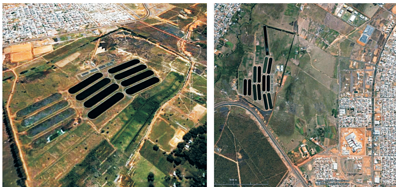
Figura 69 Vistas aéreas de las ETES Santa María y Alagados en Santa María
